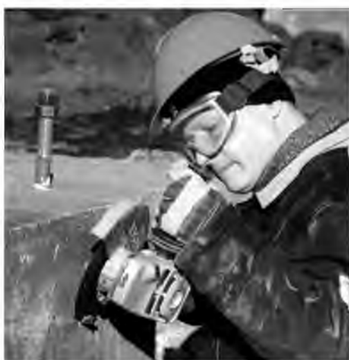
Электрогазосварщик Виктор Семерников проводит зачистку поверхности фундамента под металлоконструкции
