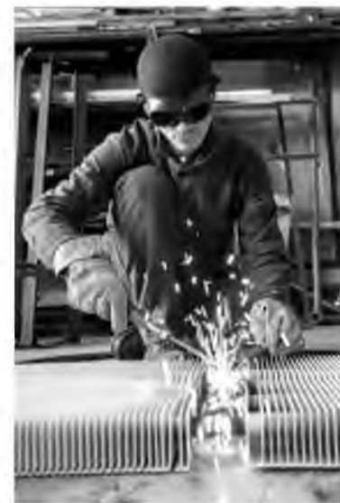
Газоэлектросварщик Альфир Абдиев производит сборку конвектора для системы отопления корпуса 131
