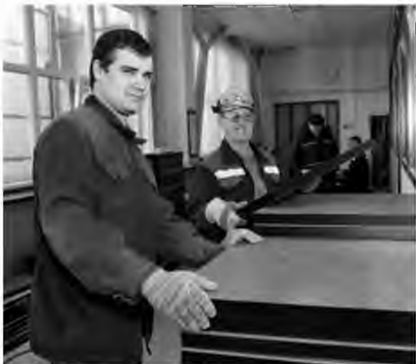
Плиточники-облицовщики Андрей Шикханов и Александр Грошев проводят замену фальшпола на ЦПУ пятого агрегата
