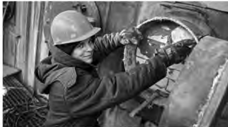
Специалисты цеха № 63 проводят ремонт футеровки на котле 24 В-1
