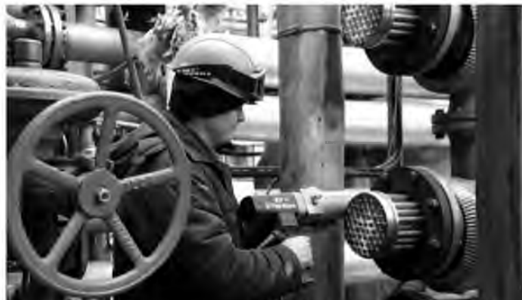
Цех №26 закрывает аппарат Е-17 после промывки теплообменных труб
