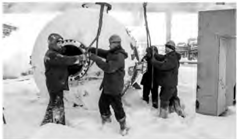
Демонтаж газовых сепараторов на главной эстакаде поручен цеху №100
