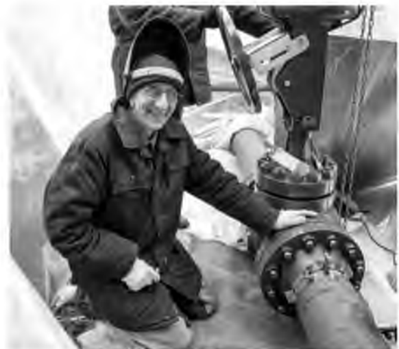
Цех №26 монтирует новые клапана на блоке №7
