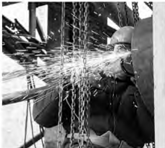
Замену линии оборотной воды на ВОЦ-1 ведет цех №118
