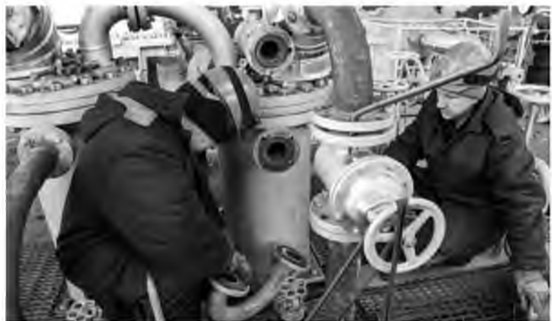
Сборкой пусковых эжекторов компрессора К-402 в отделении компрессии занимается цех №22
