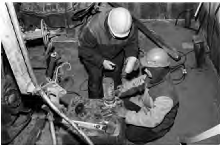
Цех №100 в отделении компрессии выполняет переобвязку конденсатных насосов Р-462
