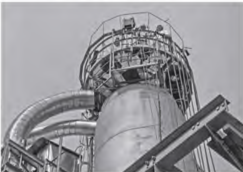
В ходе капремонта второго агрегата аммиака основное внимание направлено на ремонт отделения синтеза, замену котлов-утилизаторов на отделении риформинга и насоса питательной воды J-101A
