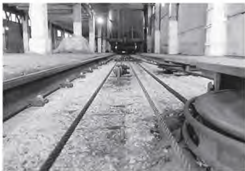
Путь №18 с отремонтированным карпуллерным устройством под погрузку карбамида уже сдан в эксплуатацию
