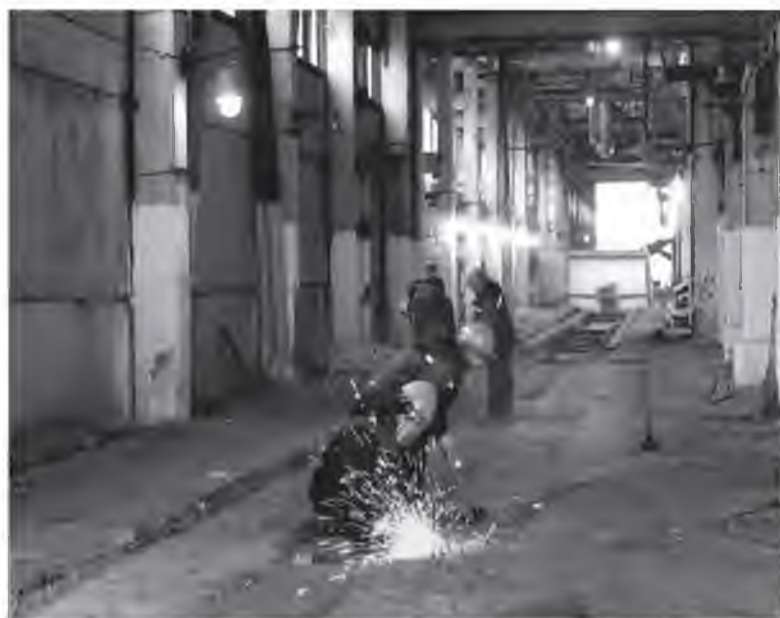
Представители подрядной организации ведут ремонт погрузочного пути №20 в корпусе №510 железнодорожной отгрузки карбамида
