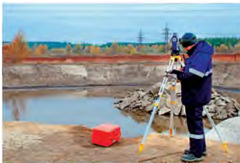
Ход ремонтных работ находится под контролем специалистов нескольких служб
