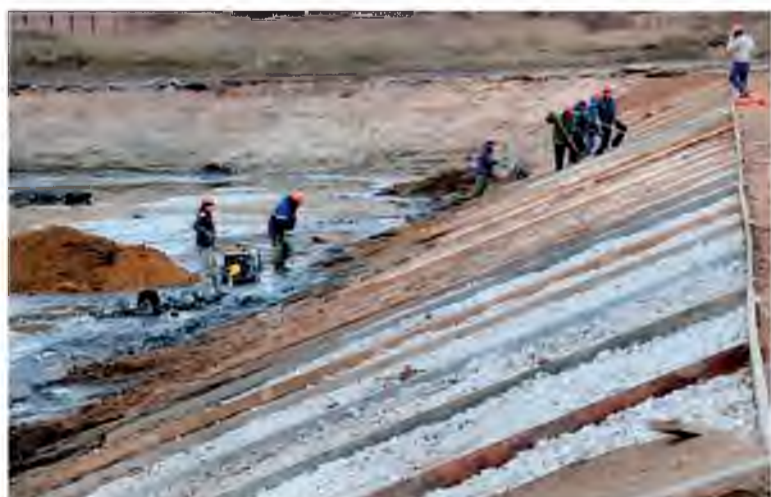
Восстановление откоса дамбы – процесс трудоёмкий и поэтапный
