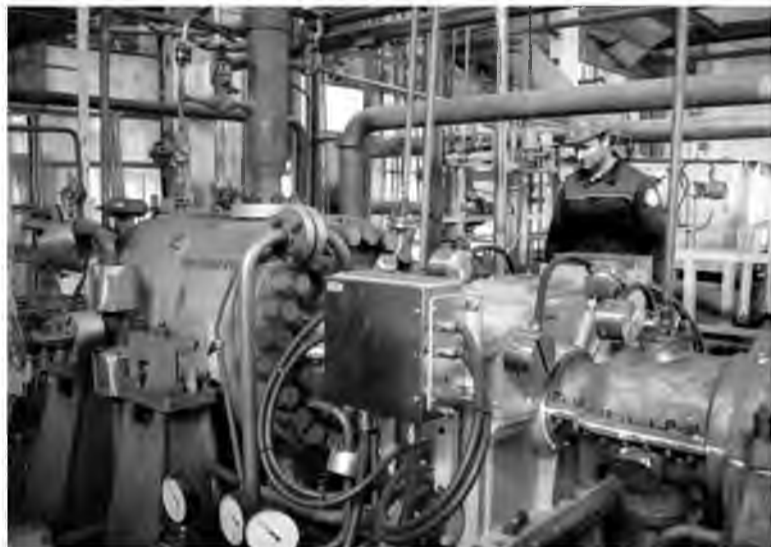
В ходе капремонта большое внимание было уделено компрессору CO 2 . За счёт устранения неисправностей производительность компрессора при прежних показателях расхода по паре значительно выросла
