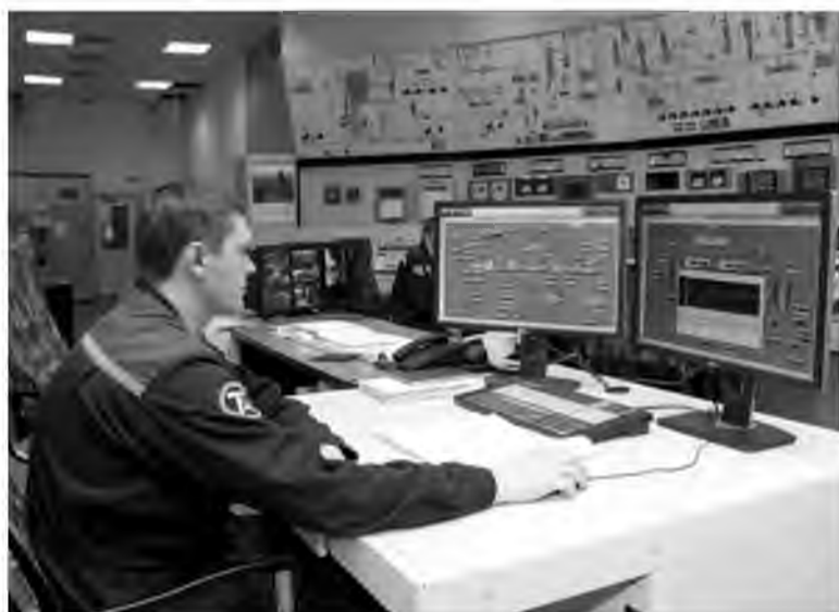
Одно из главных отличий новой АСУ ТП отделения компрессии – вывод всех мнемосхем на управляющие компьютеры ЦПУ
