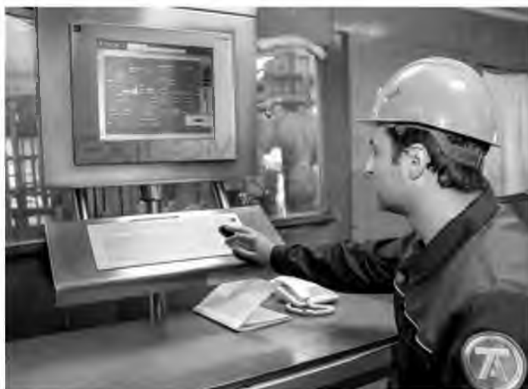
На отделении компрессии установлена автоматическая система управления Yokogawa Electric Corporation
