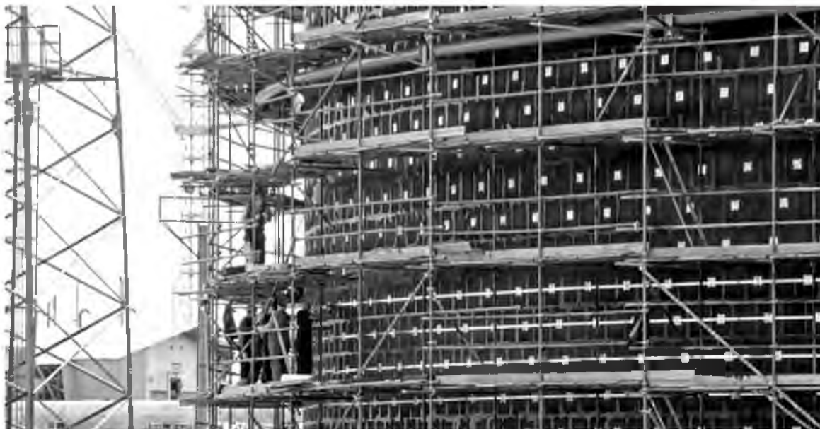
Капитальный ремонт второго хранилища – Т-02 (А) – был выполнен в 2015 году
