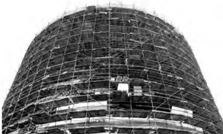
Всего на Тольяттиазоте установлены два изотермических резервуара общим объёмом 60 тысяч тонн. Ёмкости предназначены для хранения жидкого аммиака при температуре -31, -33°C
