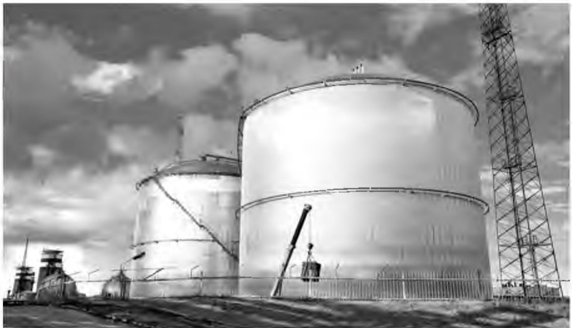
Всего на Тольяттиазоте установлены два изотермических резервуара общим объёмом 60 тысяч тонн. Ёмкости предназначены для хранения жидкого аммиака при температуре -31, -33°C
