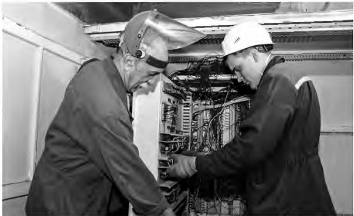
Цех №28 ведёт подключение новой АСУ ТП компрессора CO 2
