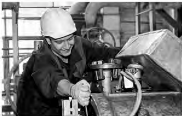
Слесарь-ремонтник цеха №25 Руслан Казак занимается центровкой турбокомпрессора поз. 11-ТК-1
