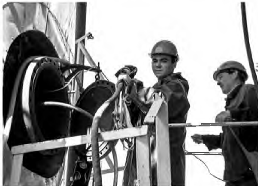
Цех №26: бригада Евгения Кирюшечкина производит чистку внутренних устройств аппарата позиции 901А при помощи установки «Хаммельмани»
