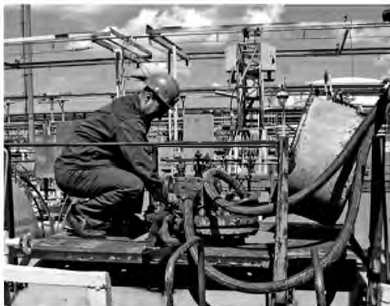
Демонтаж и монтаж оборудования вёлся силами цеха №13. На фото: слесарь-ремонтник Иван Едоков
