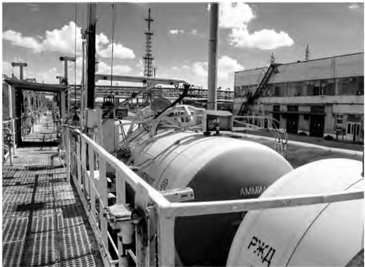
После проведённого ремонта эстакада задействована в полном объёме
